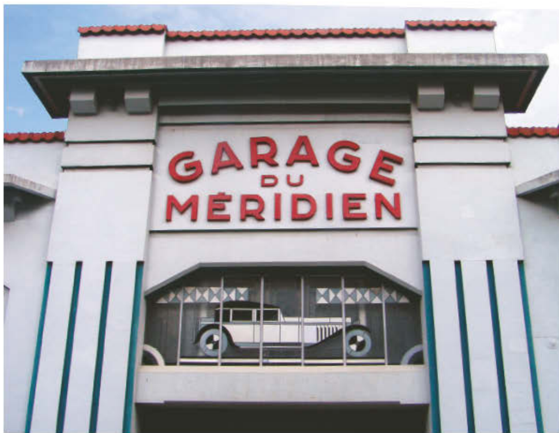
A Charbonnières, la façade du garage du Méridien, construit à la demande d'André Citroën, arbore encore son superbe vitrail Art déco.
